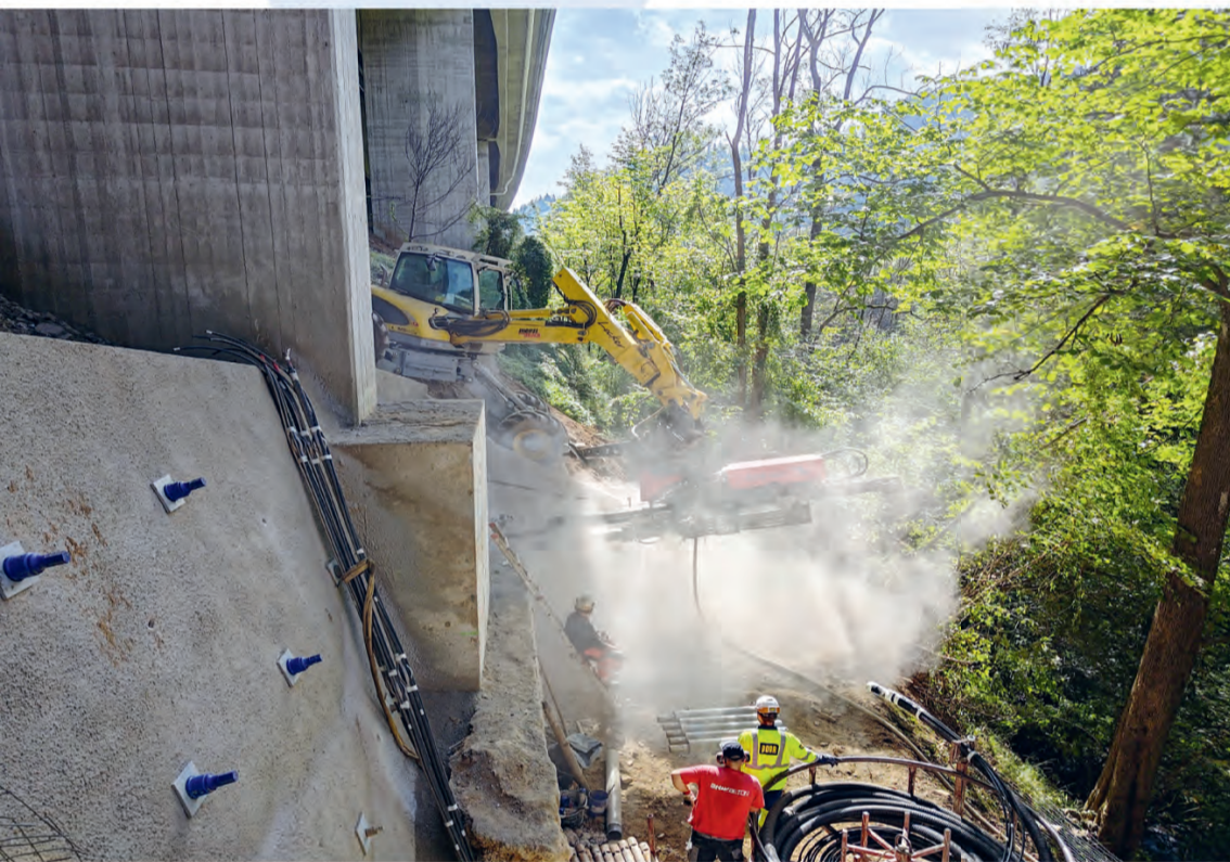
Schreitbagger-Lafetten benötigen einen Stützfuß, um sich sicher durch das Gelände zu bewegen: Andreas Locker hat mit seinem Menzi Muck viele Doppelkopf-Lizen-Anker-Bohrungen durchgeführt.
