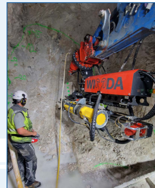
Einsatz im Tunnel WIDA AB C20 T-4
