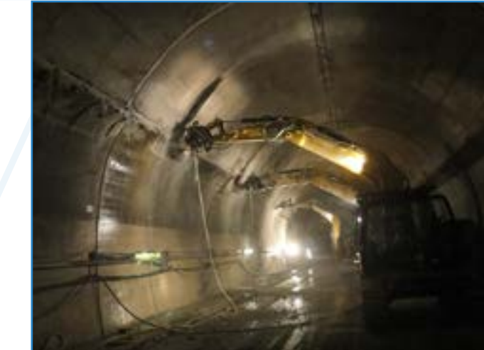
Fräseinsatz im Tunnel
