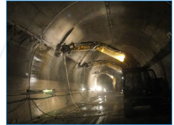
Fräseinsatz im Tunnel
