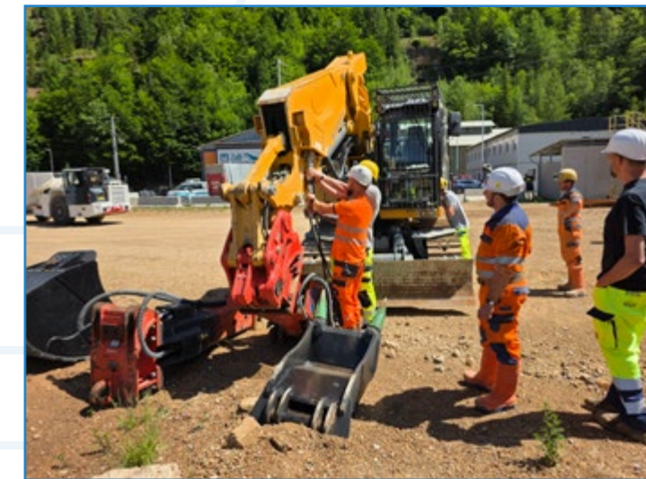
Tunnelbautechniker-Schulung am ZaB/Eisenerz am Tunnelbagger yellow Fox mit Anbaugeräten
